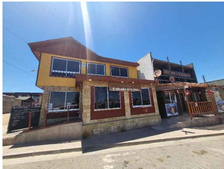
Fuente: terreno de reconocimiento 15- 16 diciembre 2023.
