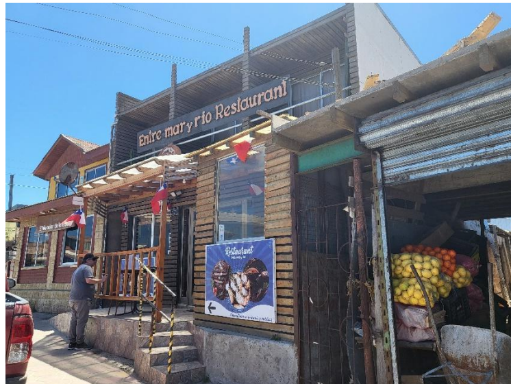
Fuente: terreno de reconocimiento 15- 16 diciembre 2023.
