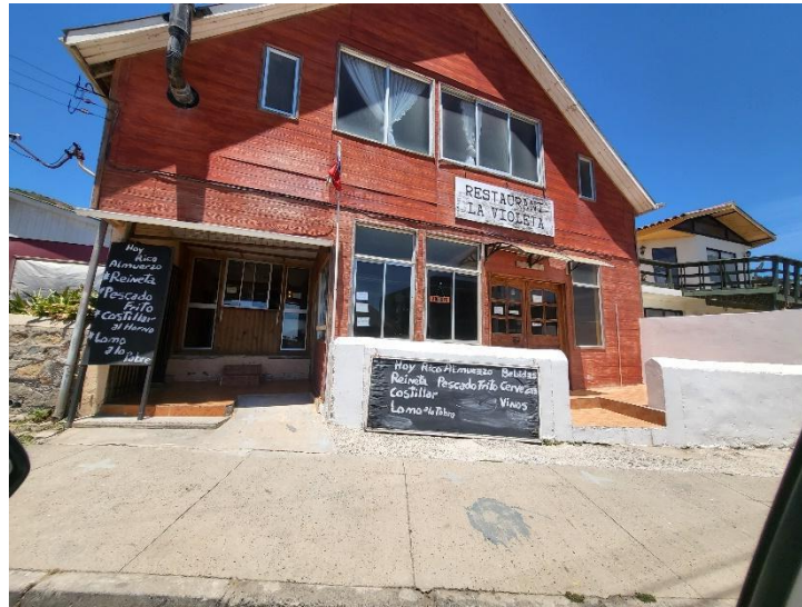
Fuente: terreno de reconocimiento 15- 16 diciembre 2023.
